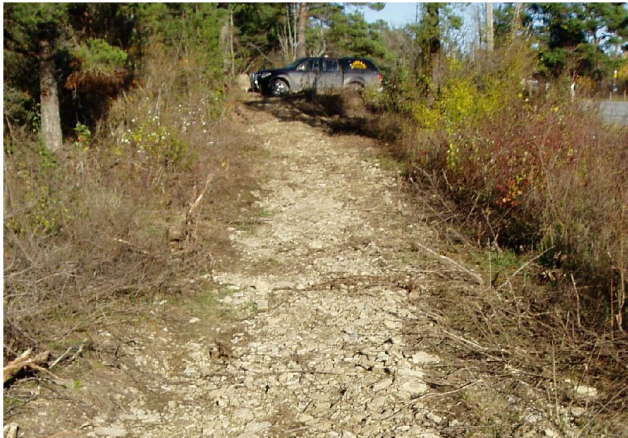
Exempel på återställning av fräsning i berg
